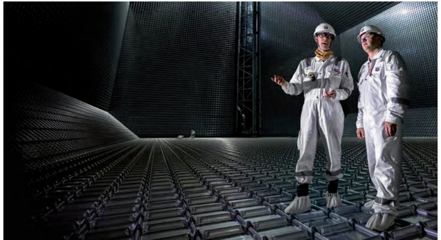
Ingegneri di Chevron controllano una cisterna LNG
